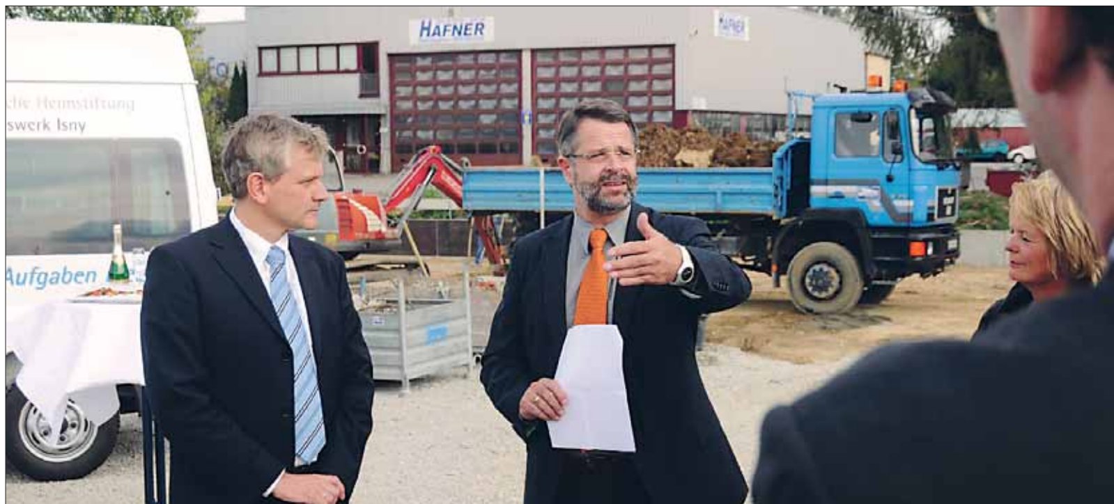
„Wir investieren in Leutkirch 640 000 Euro“, sagte Ralf Oldendorf (Mitte), Prokurist der Evangelischen Heimstiftung Stuttgart, beim ersten Spatenstich für ein neues Werkstattgebäude in der Nadlerstraße. Links im Bild Leutkirchs OB Hans-Jörg Henle. SZ-Foto: Jürgen Spöcker
