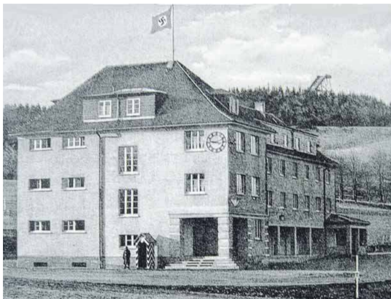
Der Hauptbau mit der Hakenkreuz-Fahne auf dem Dach. Im Hintergrund ragt die einstige Skisprungschanze aus dem Wald auf der Felderhalde.
