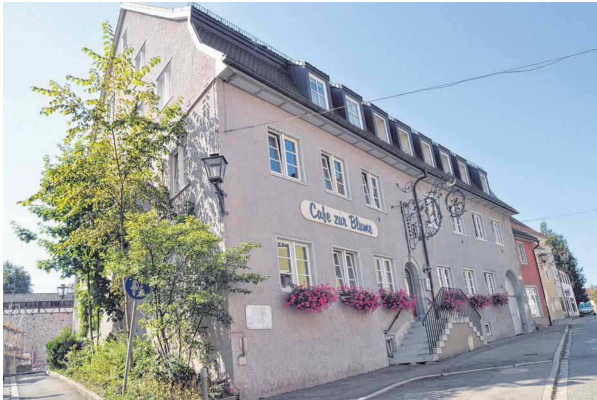
In diesem Haus in der Obertorstraße ist noch bis Anfang Oktober das Vitas-Pflegeheim.
