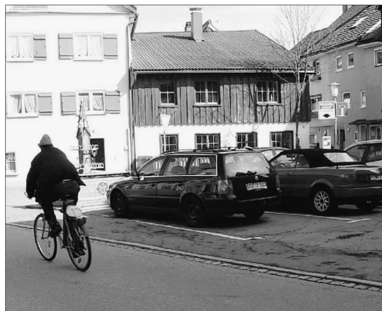
Von Autos zugaparkt, mit altersschwachem Asphalt und dem Brunnen als einzigem Schmuckstück – so präsentiert sich der Annaplatz in Isny derzeit. Doch bald soll alles besser werden: Der Technische Ausschuss stimmte jetzt für eine Sanierung des Bereiches, über eine Begrünung wird noch nachgedacht. SZ-Foto: Sabine Centner
